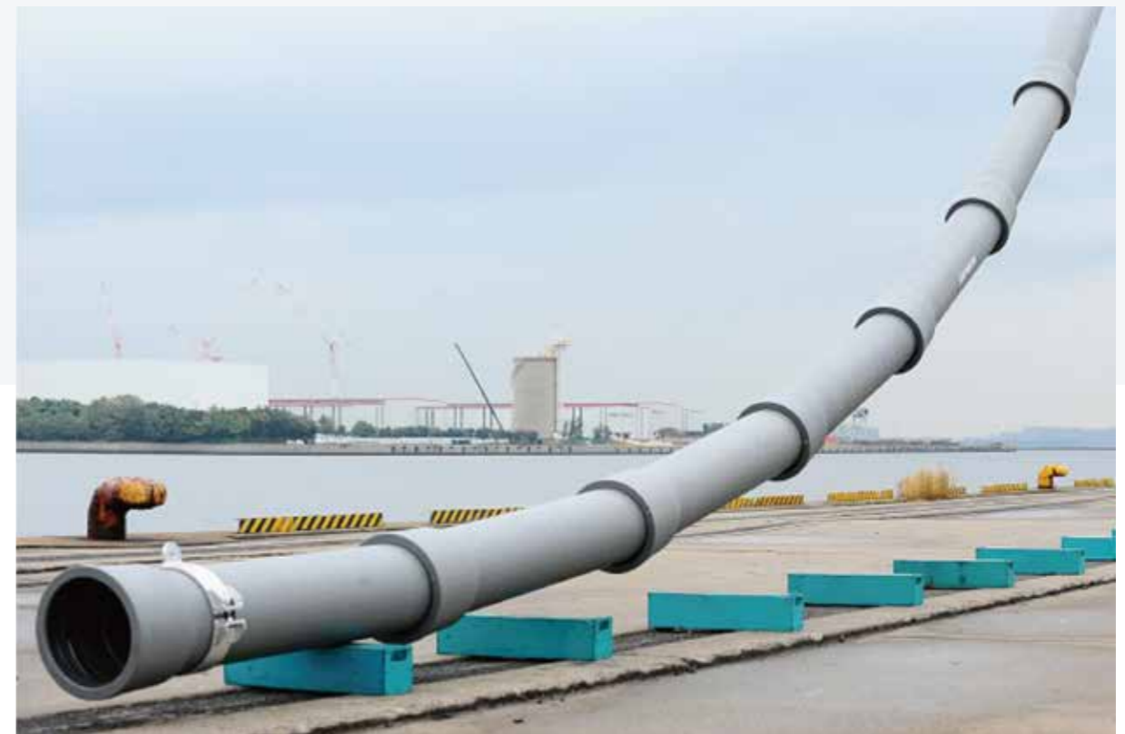
耐震型ダクタイル鉄管GENEX (GX形) 吊上げ(継手性能確認)試験
