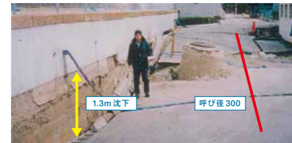
地盤沈下 | 阪神・淡路大震災、兵庫県神戸市
