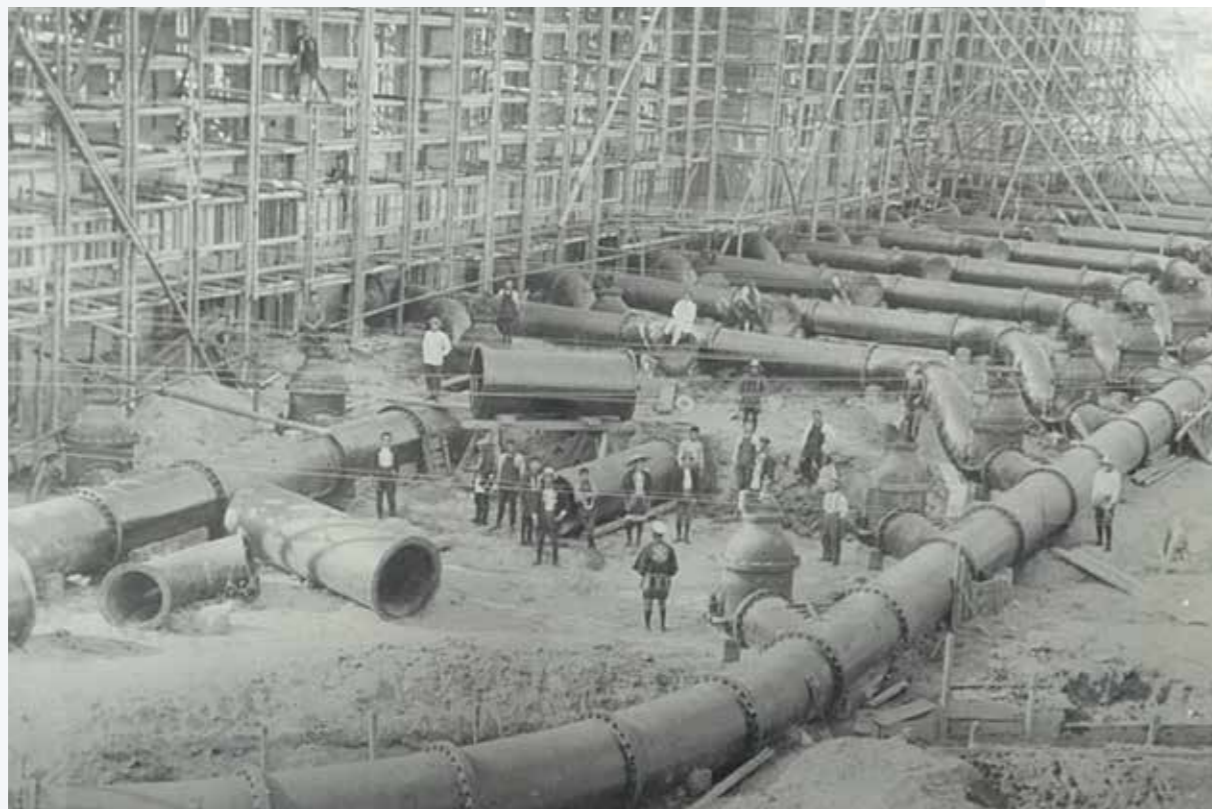
大阪市水道第2回拡張工事 1914年(大正3年)
