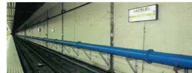
鉄道(湧水の排水管)
